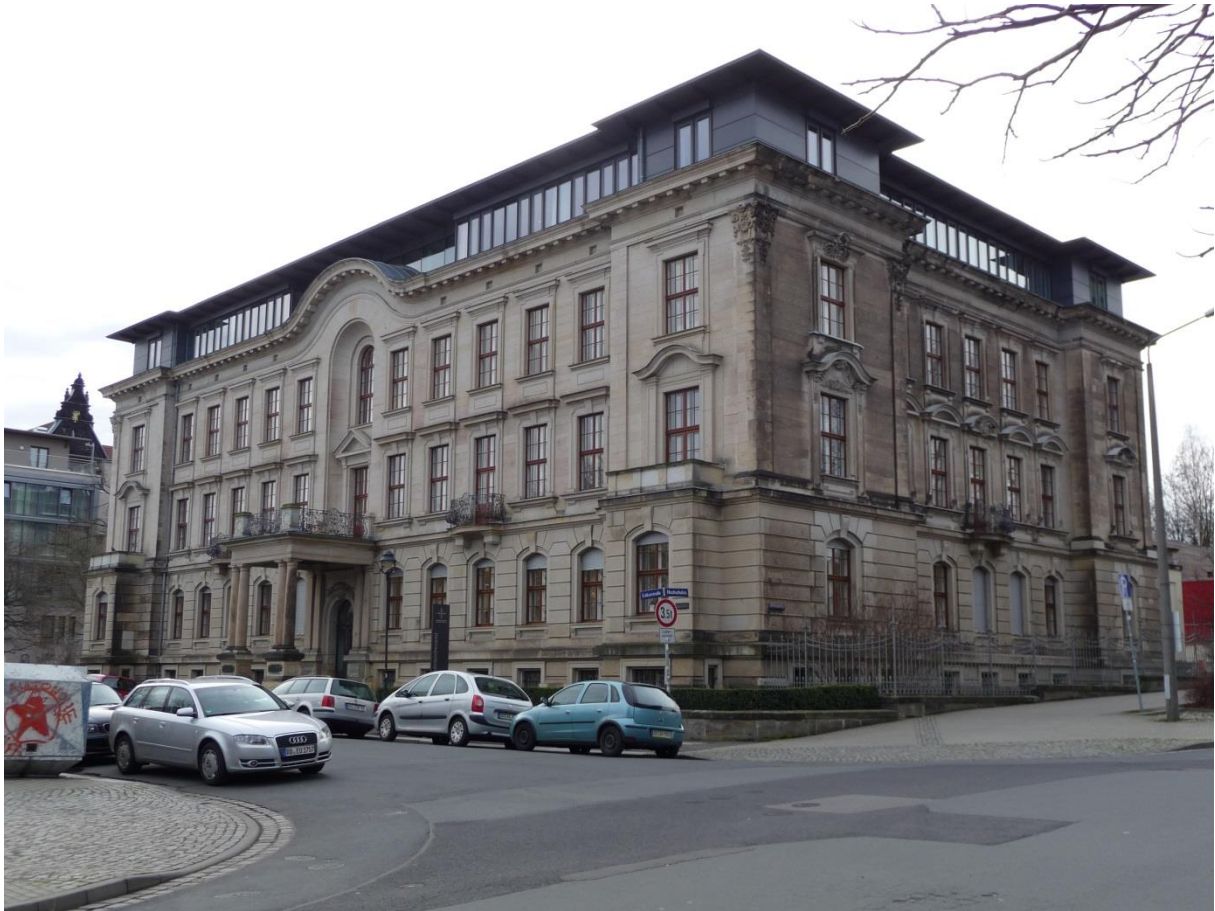
Dienstgebäude Dresden, Lukasstraße 6 von Norden
