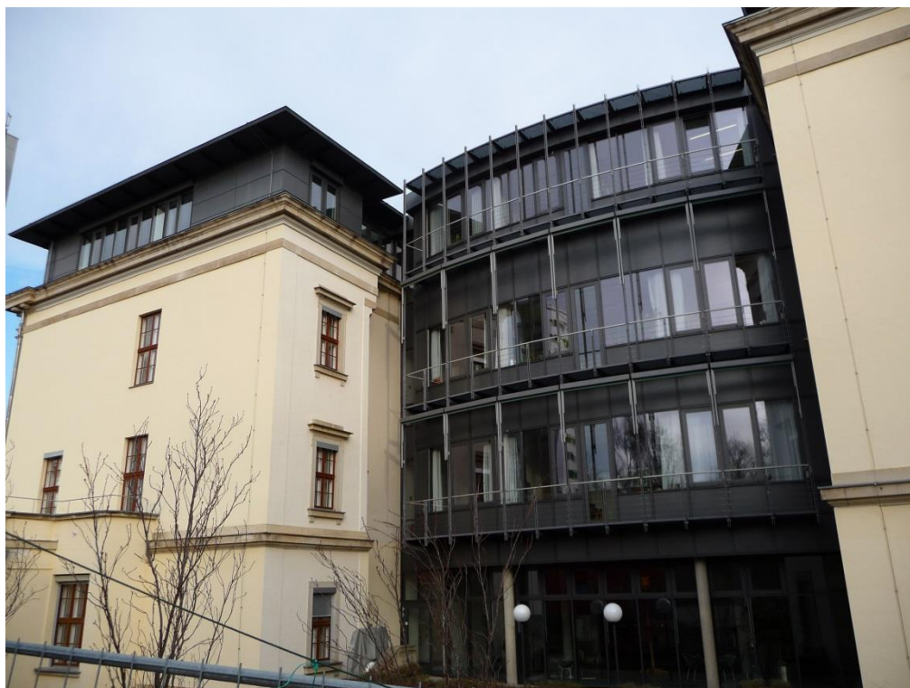
Südseite des Gebäudes mit eingefügtem Neubau
